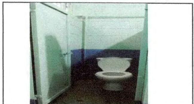
Foto 4: SERVICIOS SANITARIOS Y SUS ACCESORIOS
