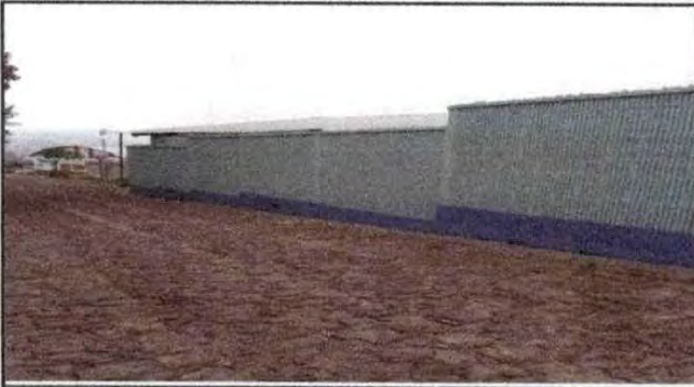
Foto 1: PINTURA EN MUROS EXTERIORES E INTERIORES
