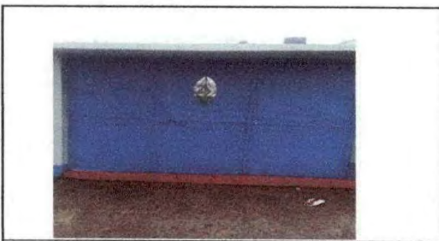
Foto 5: MANTENIMIENTO A PORTONES
