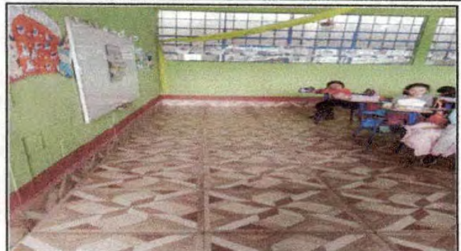
Foto 2: PINTURA EN MUROS EXTERIORES E INTERIORES
