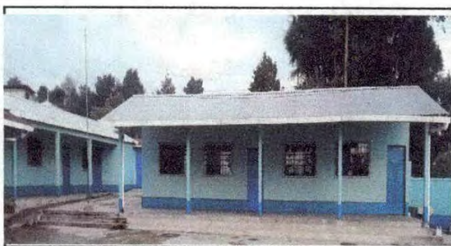
Foto 5: CANALES Y BAJADAS DE AGUA FLUVIAL
