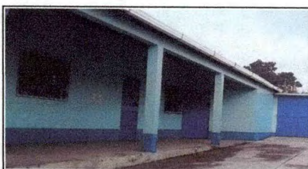
Foto 6: CANALES Y BAJADAS DE AGUA FLUVIAL
